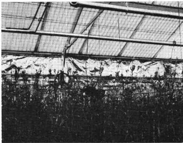
Feuille d'aluminium sur face « Nord » de la serre, en vue d'augmenter la lumière à l'intérieur de la serre, U.S.A., 1966
