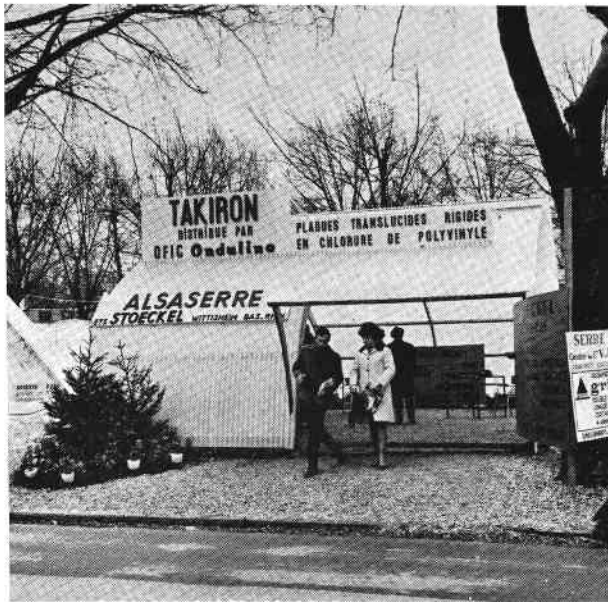
STOECKEL - O.F.I.C. : serre à armature en bois lamellés collés et couverture en plaques de PVC
