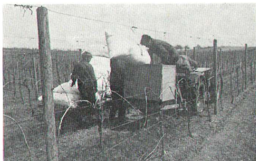
Fig. 8. — Un drainage par fentes remblayées au Styromull fait disparaître les tassements du sol et les accumulations d'eau.
