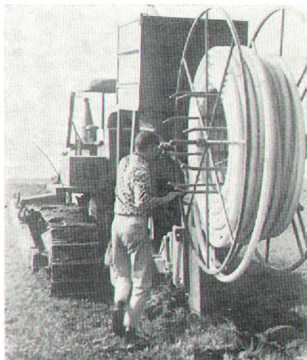
Fig. 6-7. — Styromull sert de matériau filtrant pour le drainage par tuyaux. Le drain posé à l'outil-taube est simultanément enrobé de flocons de mousse de polystyrène.
