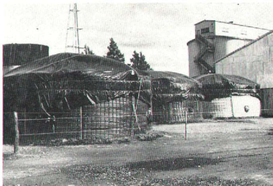
Silos temporarios para granos Silos temporaires pour les graines Tempory grain silos
