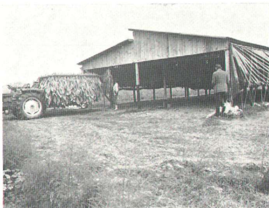
Séchoir couvert de plaques asphaltées et bordé latéralement de film P.E.
